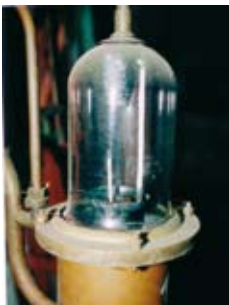
Kontrollkammer der Destillationsanlage.
