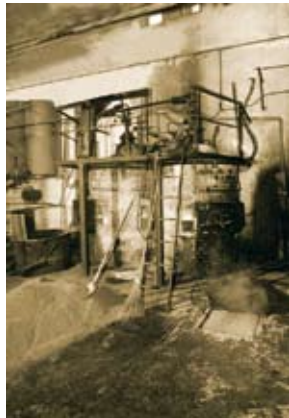
Die Destillationsanlage im Jahre 1934.
